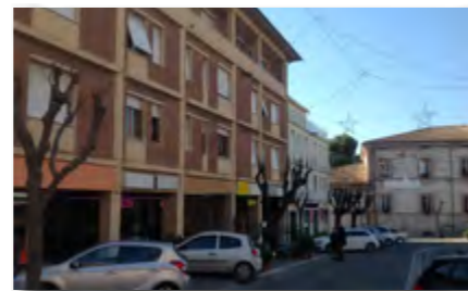
NUMANA appartamento in centro vista mare
