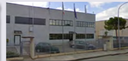
CASTELFIDARDO capannone artigianale/deposito
