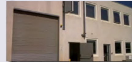
OSIMO capannone artigianale
