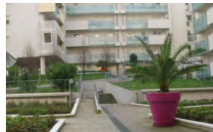
ANCONA cantiere di 12 appartamenti
