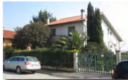
MONSANO porzione di abitazione in bifamiliare
