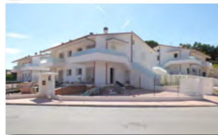
ANCONA cantiere di 12 appartamenti
