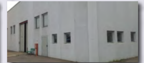
RECANATI capannone artigianale
