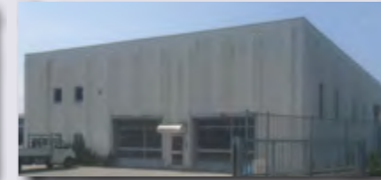
FALCONARA capannone industriale
