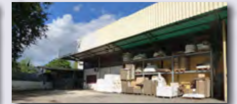
CASTELFIDARDO capannone artigianale
