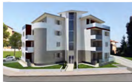
CHIARAVALLE cantiere di 11 appartamenti
